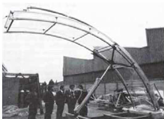
Fasi di montaggio del padiglione: il basamento e il sollevamento degli archi
