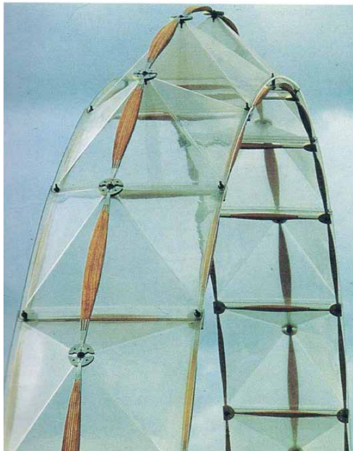
Prova di montaggio di un'arco della struttura
