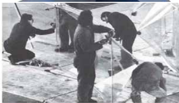
Fase di montaggio a terra delle piramidi in policarbonato
